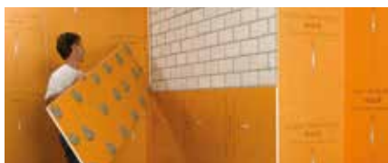
Podklad pro obkládání / konstrukční deska / kontaktní izolace
