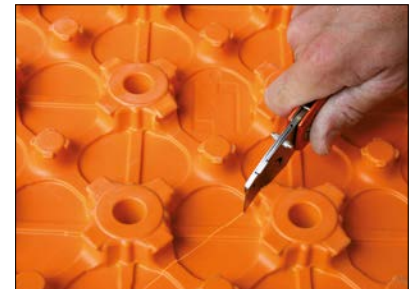
8 b Verarbeiten der Estrichnoppenplatte – Schneiden zwischen den Noppen: mit scharfem Messer/ Cutter anschneiden ... und brechen.
